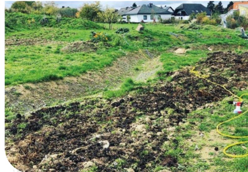
Gräben und Mulden dienen zur Wasseraufnahme und Versickerung. Durch Kompost (im vorderen Bereich) wird die Wasseraufnahmekapazität des Bodens zusätzlich verbessert.
